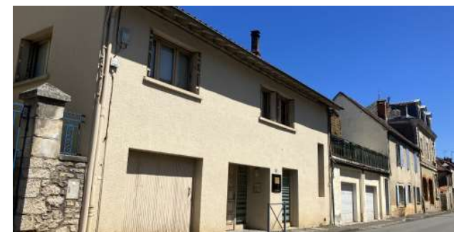
Tissu ancien, front bâti dense au Sud
