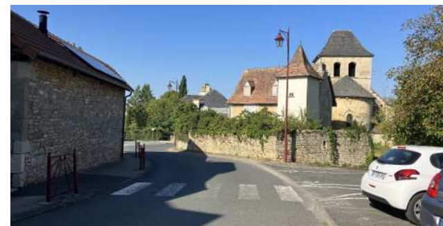
Tissu bâti historique du centre ancien
