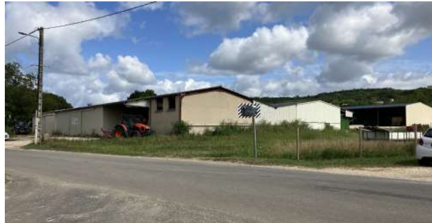
Bâtiments d'activité de la pépinière
