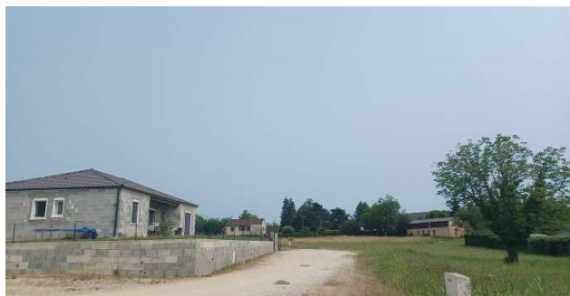
Nouveau lotissement en construction
