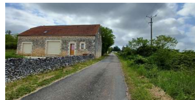
Bâti ancien et murets en pierres sèches
