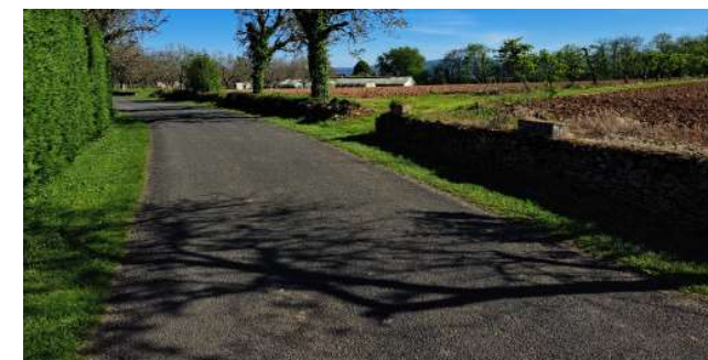
Muret en pierre le long de la voie
