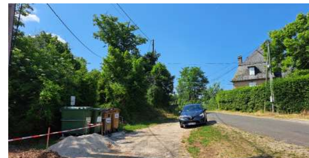
Dilatation de la RD33, au Nord-Est du site
