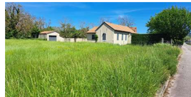
Maison ancienne rénovée
