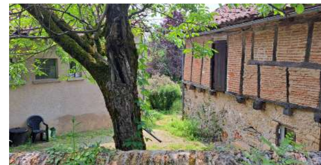
Bâti ancien au Nord-Est
