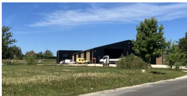
Bâtiment d'activités (menuiserie) dans le PA La Perrière
