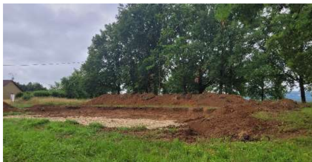
Terrassement pour fondations de nouvelles habitations
