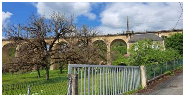
Viaduc de Présignac situé au Nord du site
