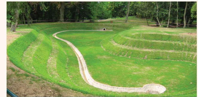
Création d'un bassin de rétention des eaux pluviales - Comptoir des projets -Essonne (91)
