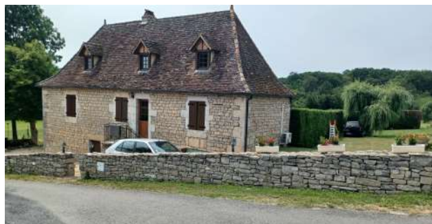
Bâtisse remarquable au Sud
