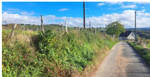
Fort talus au Sud, le long du route des Tillières
