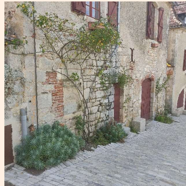
Traitement d'un pied de façade à Saint-Cirq Lapopie (46)
