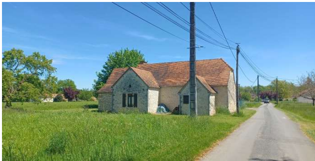
Maison ancienne enclavée dans le terrain de projet
