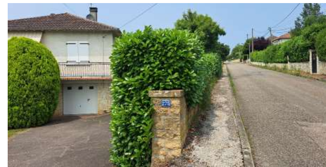
Habitation comprise dans l'emprise de l'OAP
