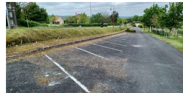
Places de stationnement le long de la route
