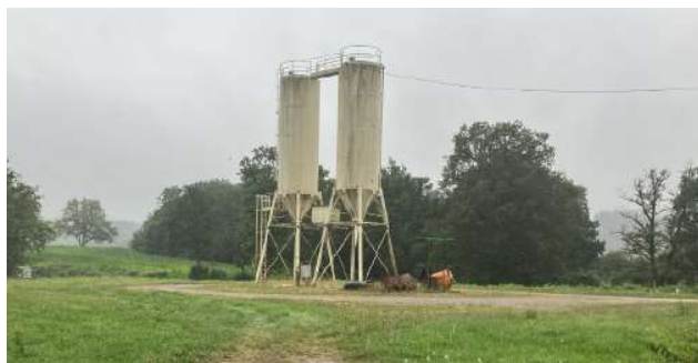
Silos présents au Sud de la parcelle
