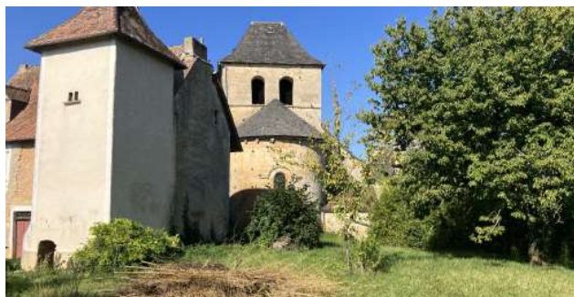
Eglise, à l'Ouest du site et vue sur pignons arrières
