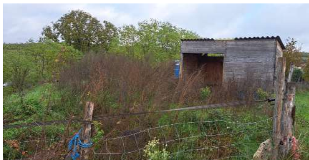
Cabanon et zone enfrichée
