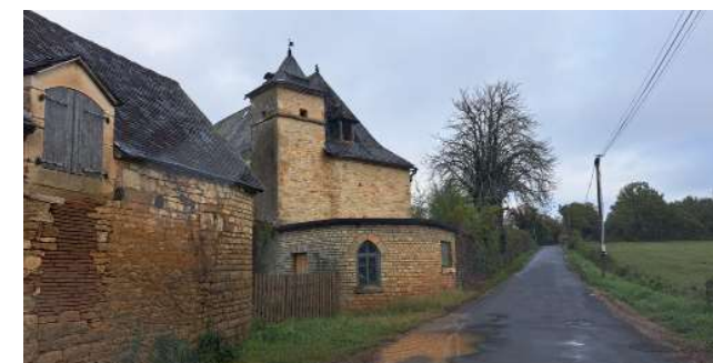
Corps de ferme avec tour pigeonnier remarquable au Nord
