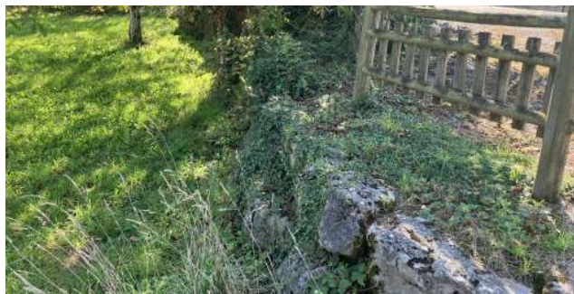
Rupture de pente marquée par le muret en pierre
