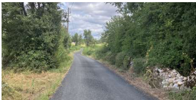
Route communale desservant le site 1
