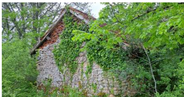
Cazelle située au centre du terrain
