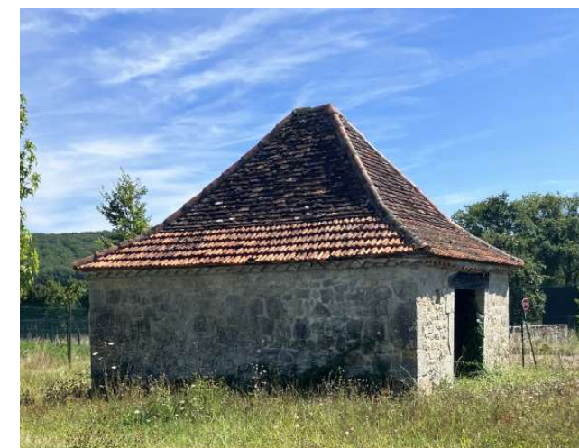
Bâti traditionnel présent au Nord du site
