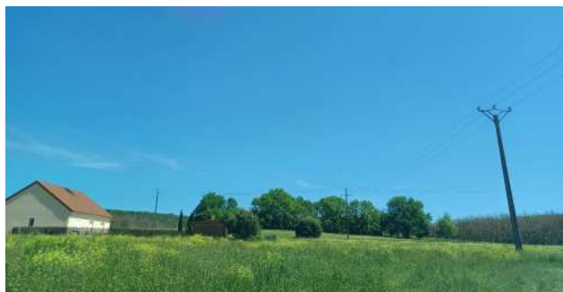
Lignes électriques qui traversent le site
