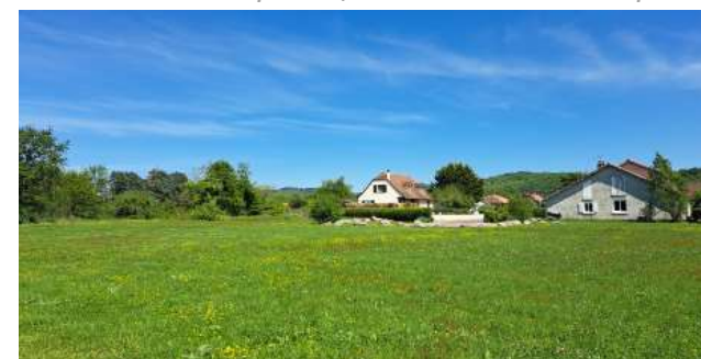
Tissu bâti hétéroène, une maison ancienne fait face à une habitation de type lotissement
