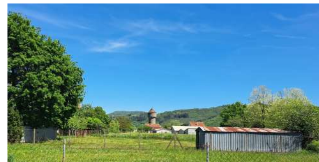
Vue sur le château d'eau
