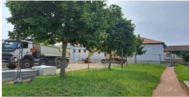
Groupe scolaire en travaux
