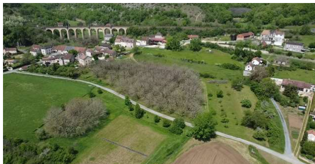
Vue drone sur le site depuis le Sud
