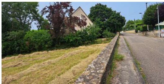
Muret en pierre longeant la voie
