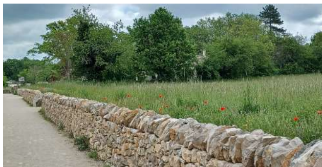
Muret en pierre sèche le long de la route départementale au Nord
