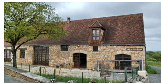
Menuiserie à l'Ouest du site
