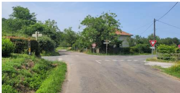
Croisement entre la RD140 et la RD134
