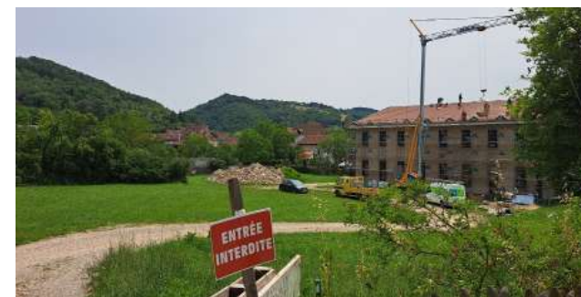
Rénovation lourde bâti ancien
